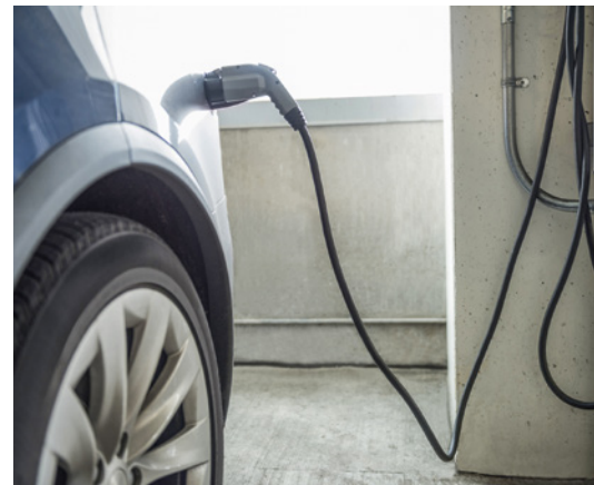
Ab jetzt wird bei der FACILITA Berlin Strom getankt – auch mit Hilfe einer eigenen und innovativen Lade-Infrastruktur.
